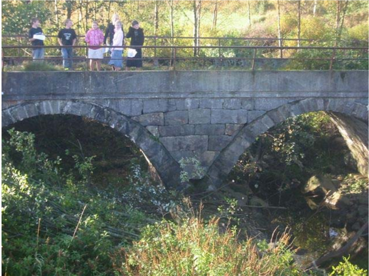
BILDE 4: GAMMEL NESEBRU. Dette bildet tok Pål (lærer) mens elevene var på den gamle Nesebrua. Under brua er det nesten helt tørt, men det ligger noen rør under brua som det renner litt vann ut av. Disse rørene går bort til hovedløpet av Hellelandsvassdraget. Ved å grave et bedre innløp kan vannstanden bedres ned langs Sleveland.
