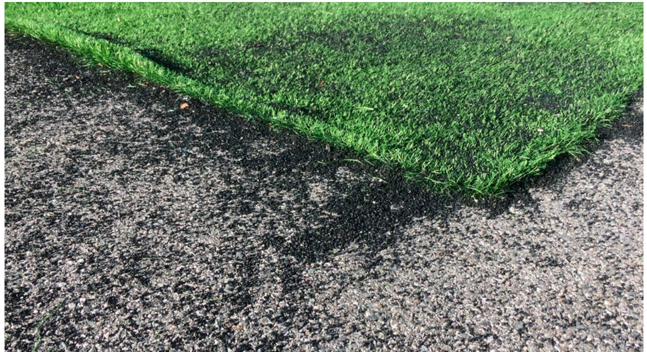
Foto: Svein Roger Dahlen, Venstøp skole.
